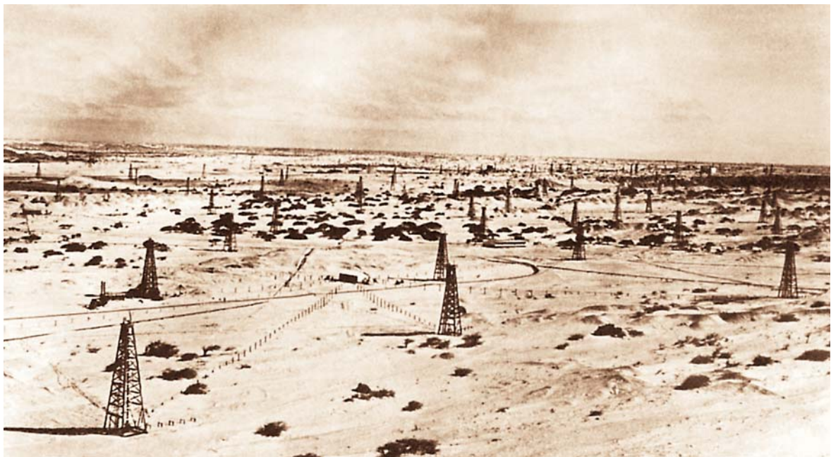
▲ Vista panorámica de los campos de Brea y Pariñas, en la década del 50 (Fotografía cortesía de PetroPerú).
