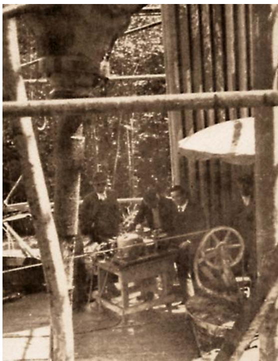
▲ Medida simultánea de la resistencia y la potencia requerida en dos máquinas de registro en Gura Ocniței, Rumania, a inicios de la década del 30.
