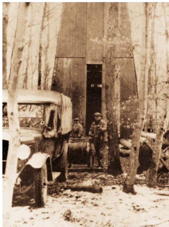
▲ Las operaciones de adquisición de registros continuaron en el campo Pachelbronn. Para el año 1929, hubo mejoras en el equipo: el cable era fabricado con tres conductores pero el torno todavía era manual. Página opuesta: Trabajo de prospección superficial realizado por Brown en el Cañón Abiti, Canadá, 1927.
