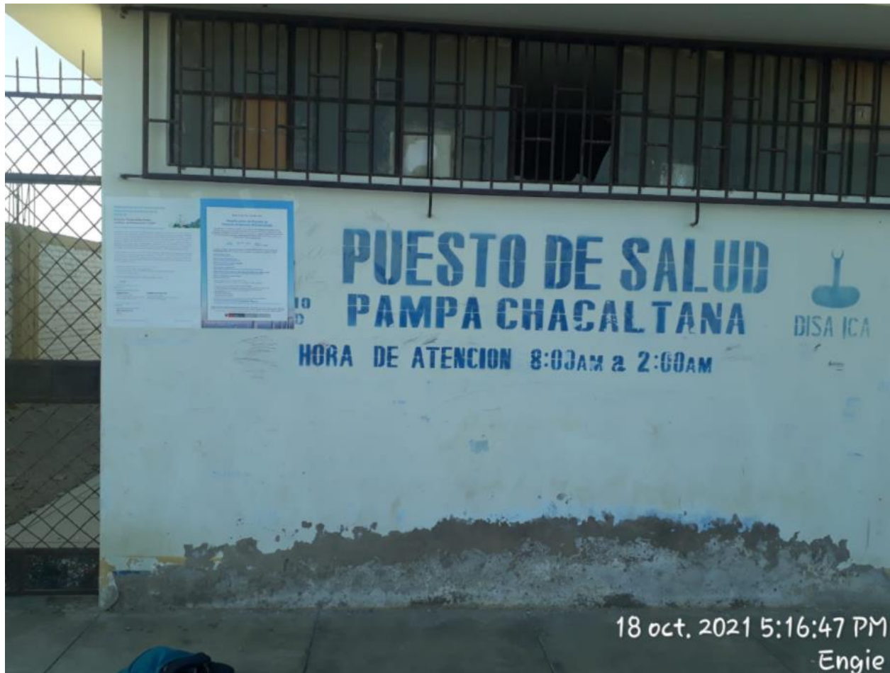
Puesto de Salud Pampa Chacaltana
