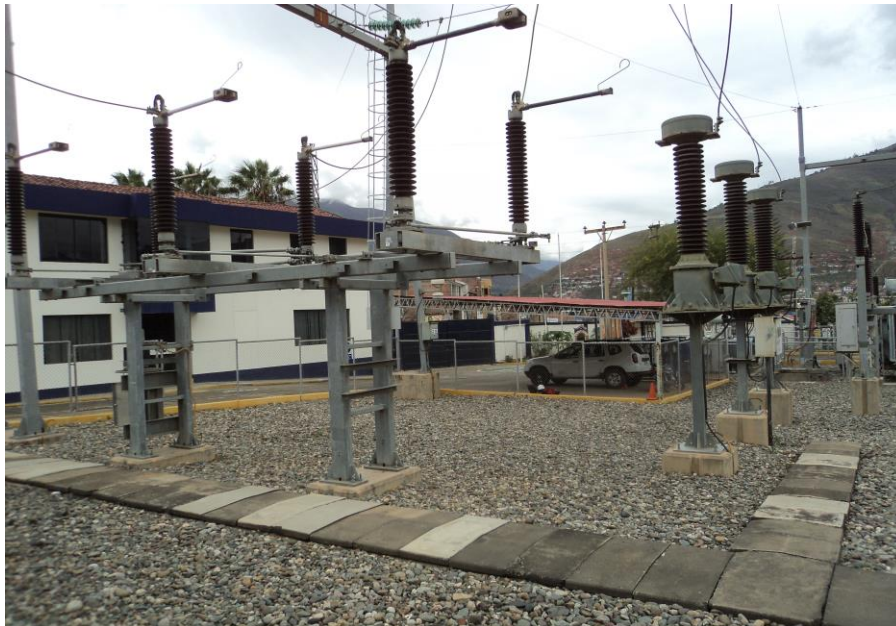
Fotografía 5.6.2.1-1 Área donde se realizarán los trabajos
