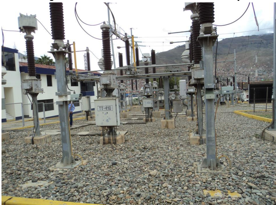
Fotografía 5.6.2.1-2 Área donde se realizarán los trabajos
