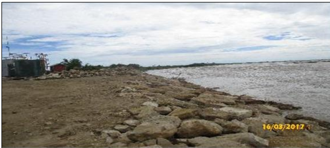
Imagen N° 3. Dique del río Chira - 2017
