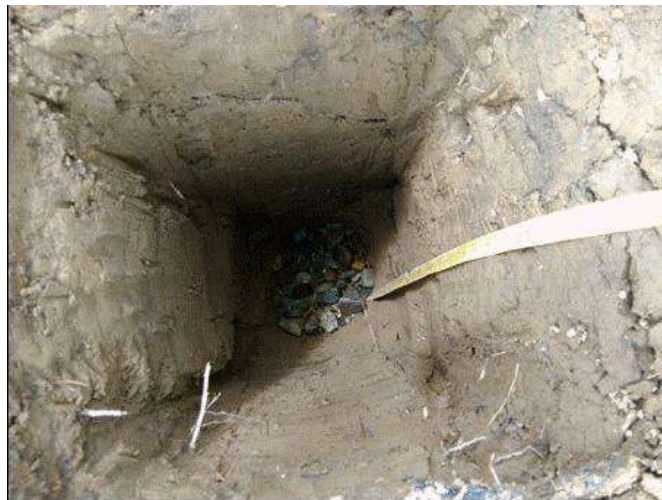
Fotografía 2. Calicata llenada hasta 5 cm con grava
