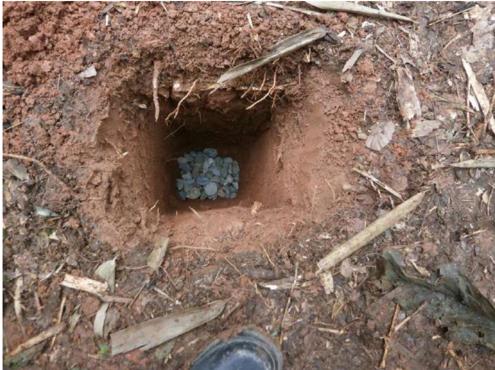
Fotografía 2: Calicata llenada hasta 5 cm con grava.
