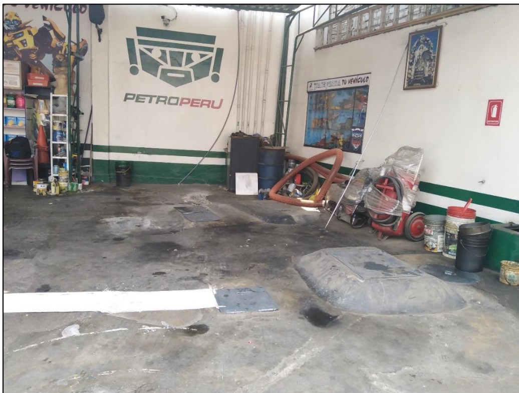
Foto N°5: Vista parcial de la zona de los tanques de combustibles líquidos y las tuberías de venteo.
