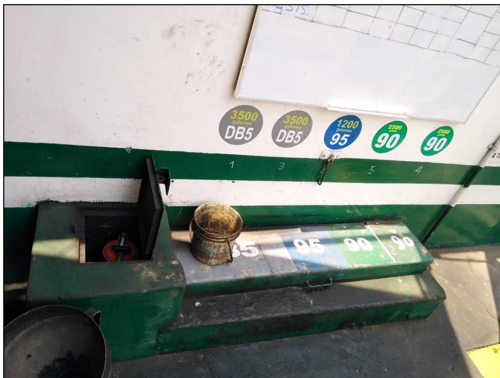
Foto N°4: Vista de la zona de descargas remotas.
