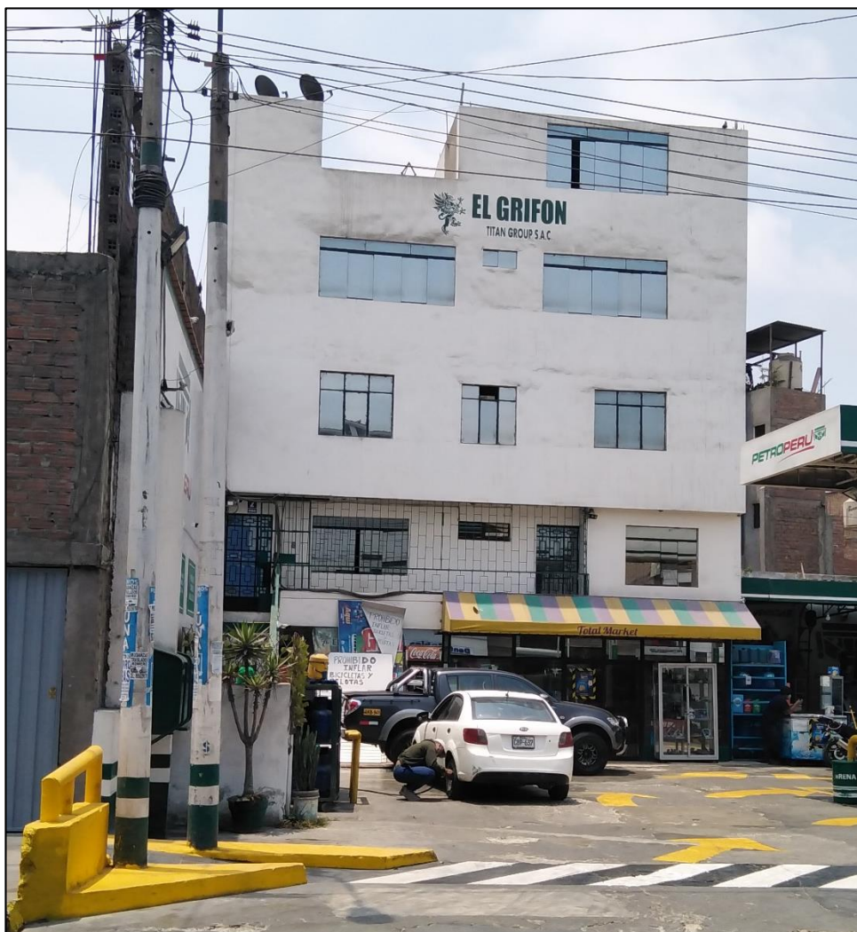
Foto N°7: Vista general de la edificación de 5 pisos existente en el establecimiento.
