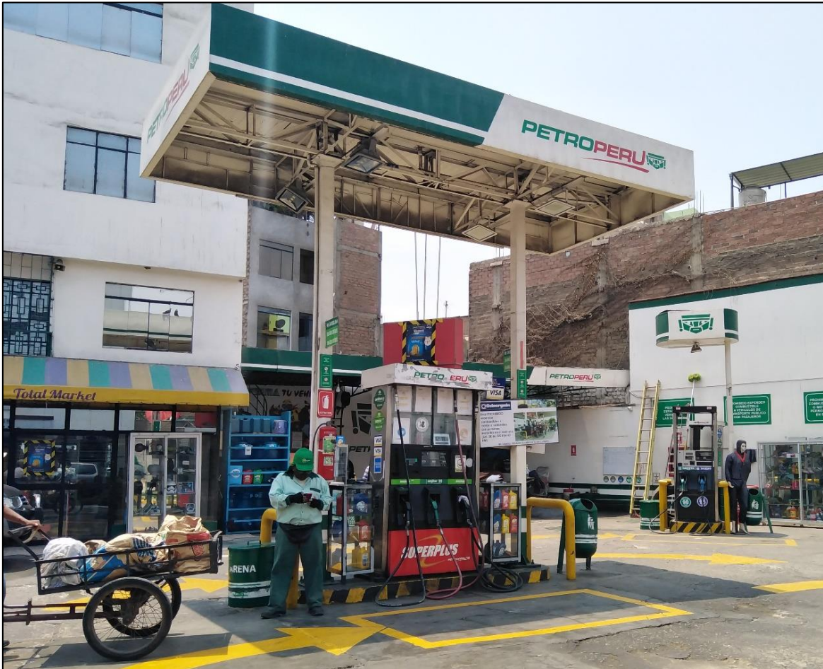
Foto N°2: Vista de la Isla de Despacho N°1 del establecimiento.
