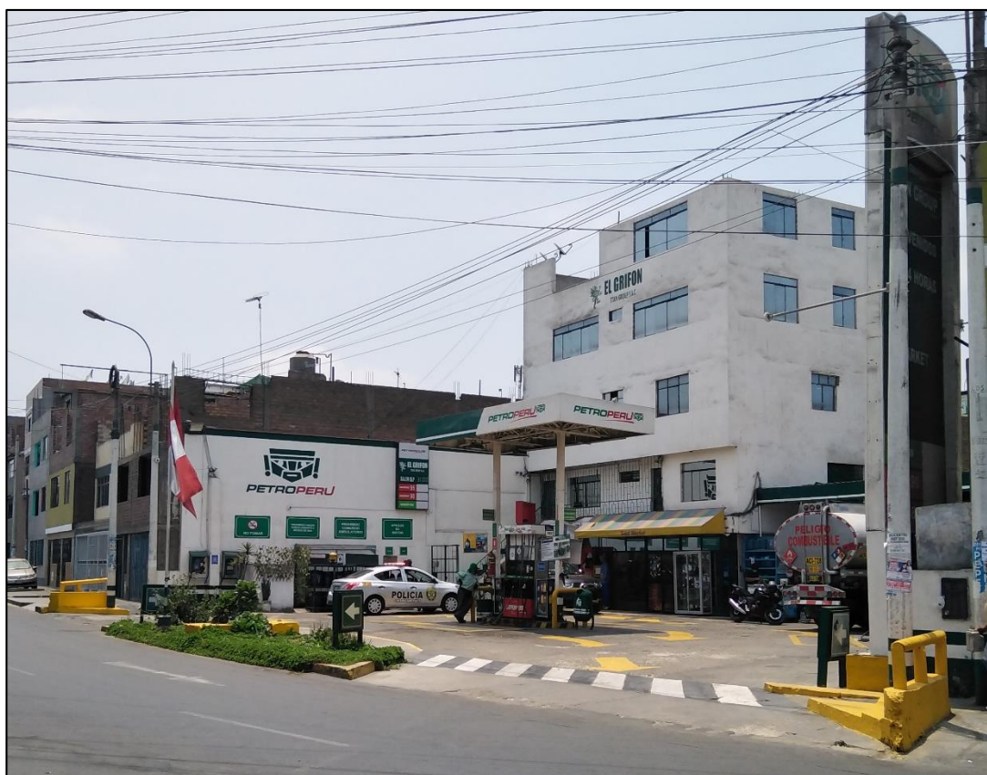
Foto N°1: Vista panorámica del frente del establecimiento.
