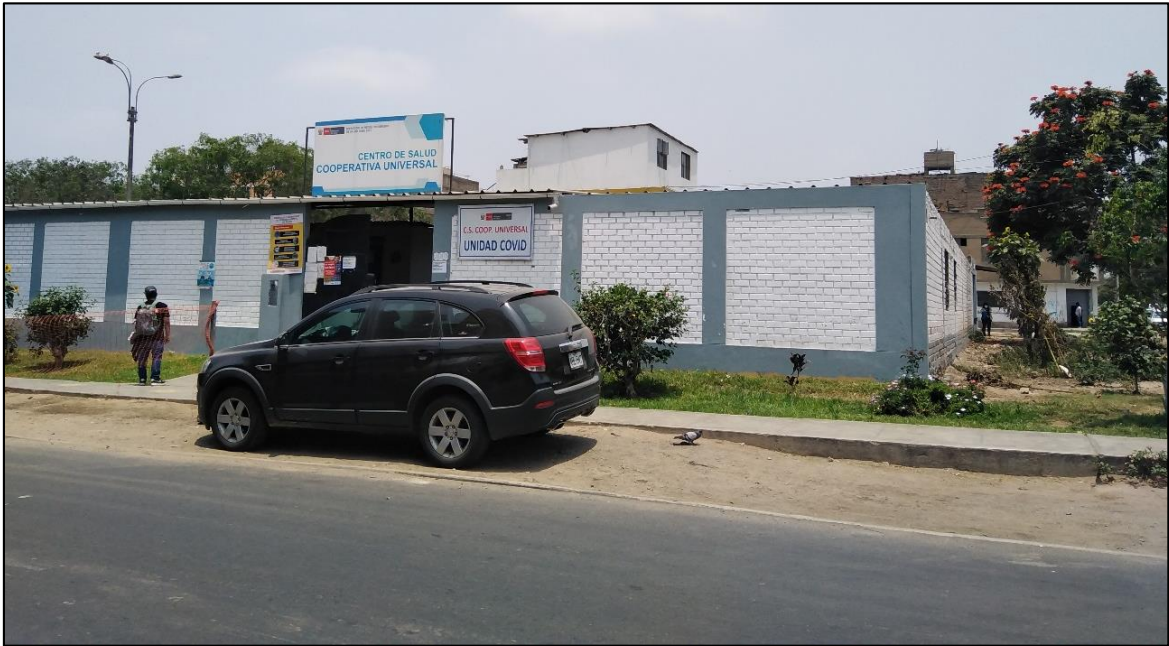
Foto N°9: Vista del frontis del Centro de Salud "Cooperativa Universal".
