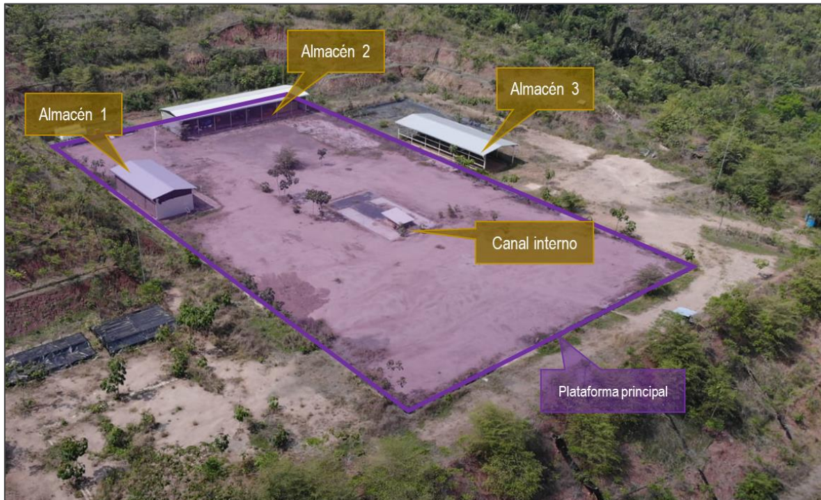
Figura 1. Instalaciones con estructuras de concreto
