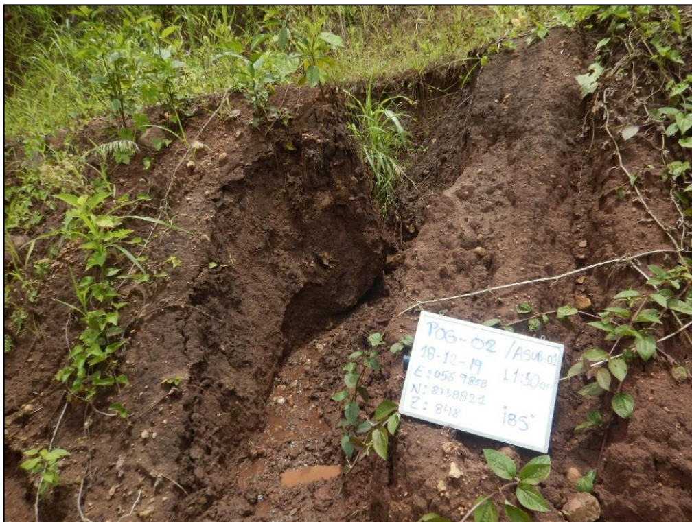
Foto 4. Depósitos coluviales conteniendo filtraciones subsuperficiales de aguas subterráneas localizadas al sur de la Locación PAD B.
