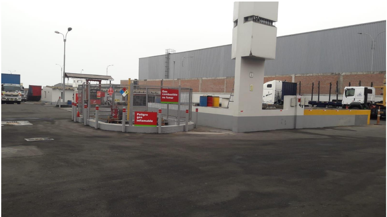
Fotografía N° 03: Zona de tanques de almacenamiento
