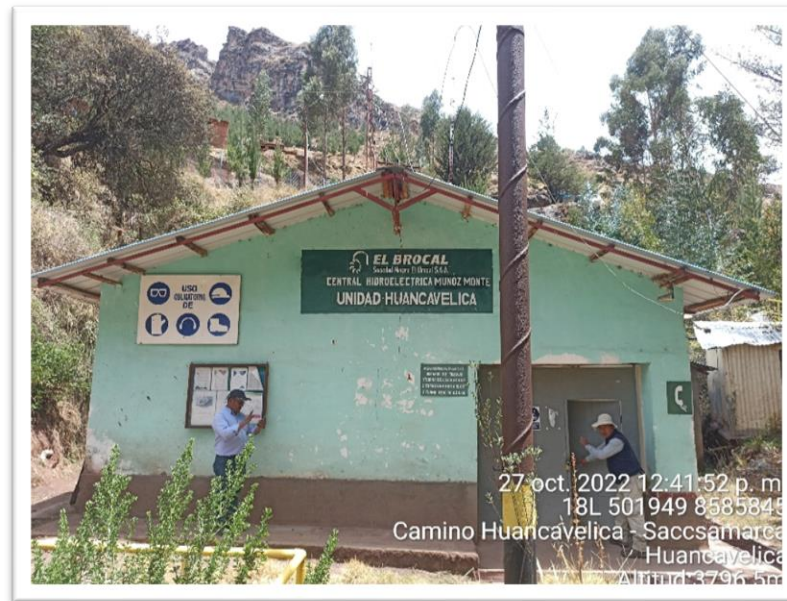
Figura 5. Casa de Máquinas
