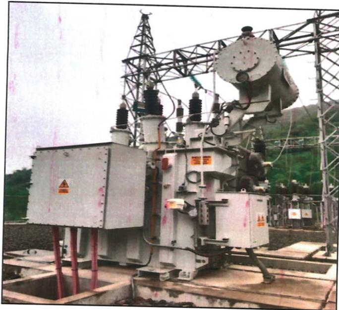
**Fotografía N°01:** transformador de potencia principal.
