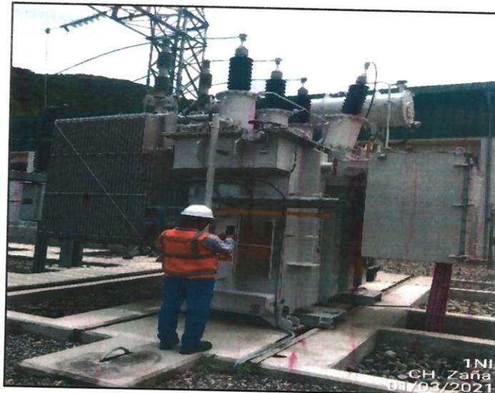
**Fotografía N°02:** Lectura de datos del transformador.
