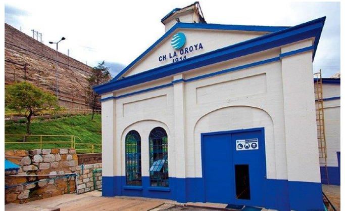
IMAGEN 7 CENTRAL HIDROELÉCTRICA ARCATA
