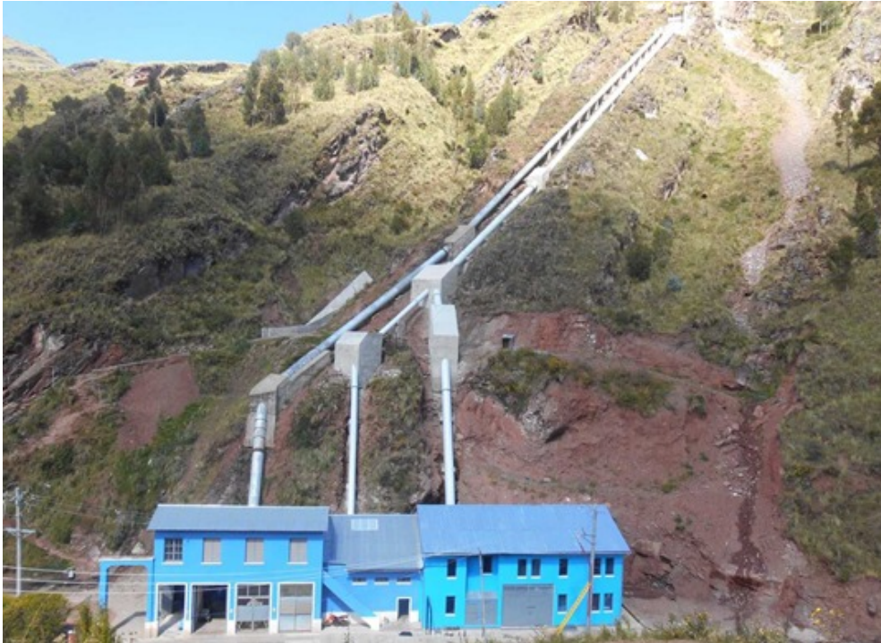
Figura 7 Tuberías Forzadas - CH Langui
