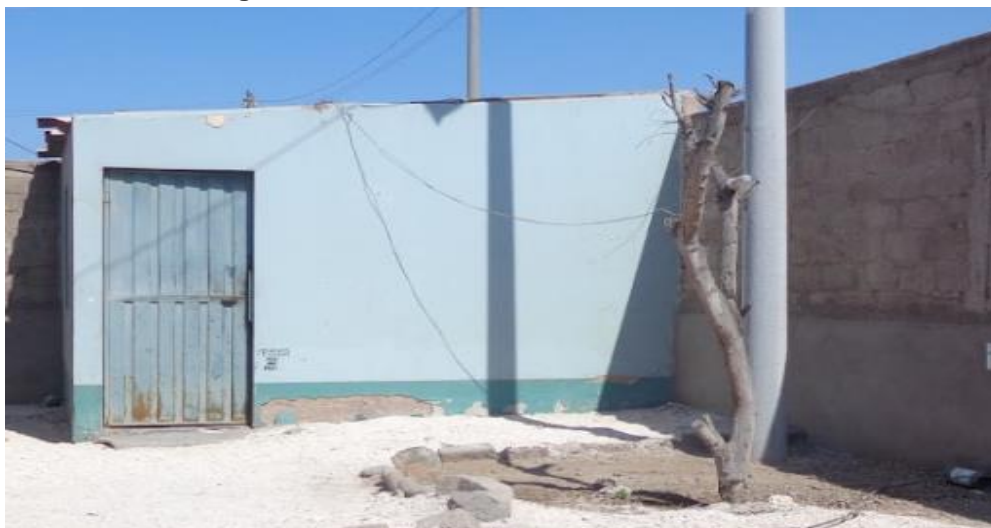
Fotografía N° 7: Vista del Almacén de Herramientas
