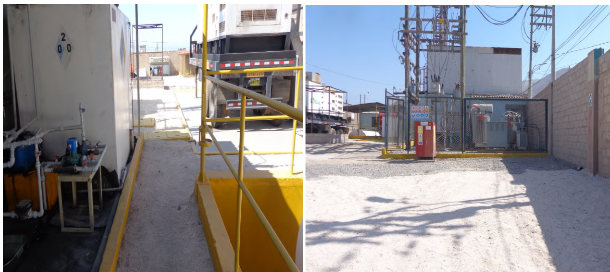
Fotografía N° 6: Vista del Patio de Operaciones
