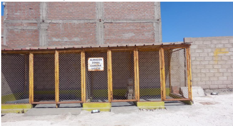
Fotografía N° 5: Vista del Almacén de Insumos
