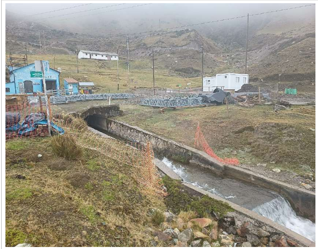
Figura 3.3 - 18 Canal de descarga
