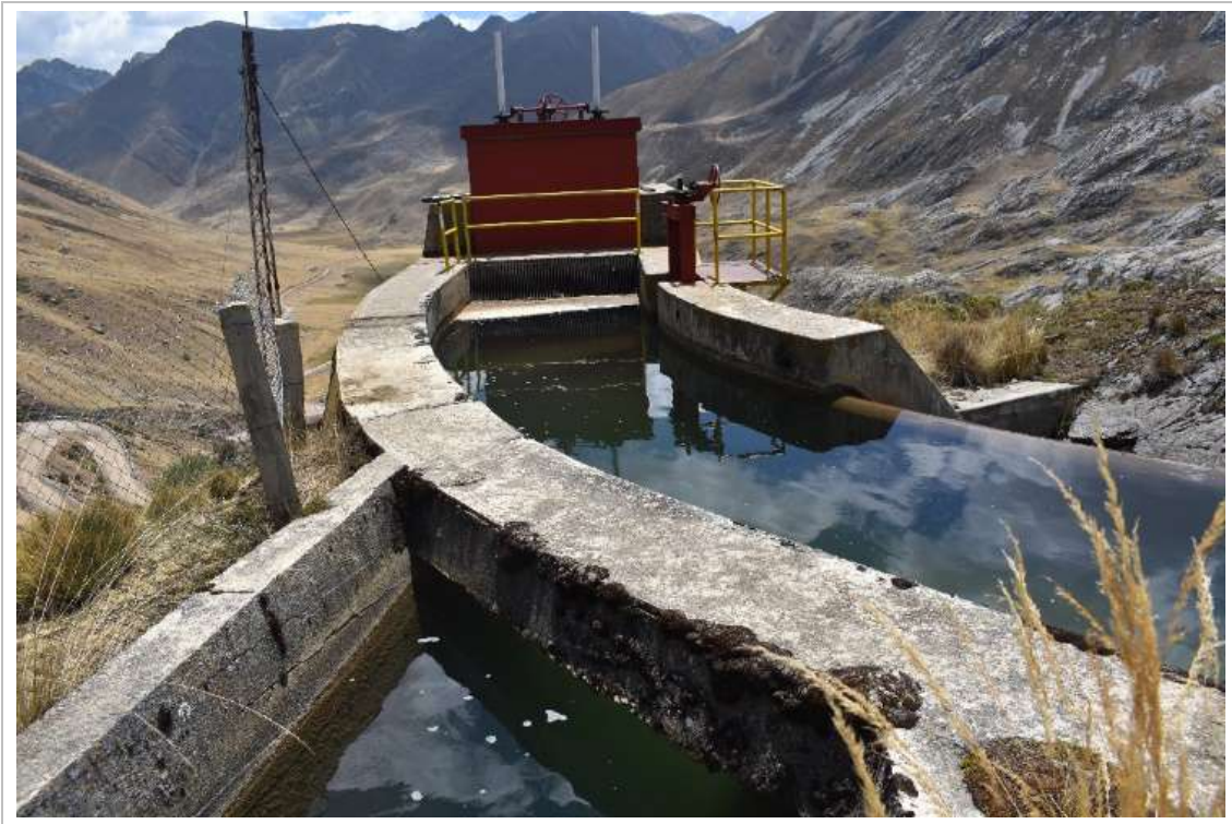
Figura 3.3 – 9 Cámara de carga
