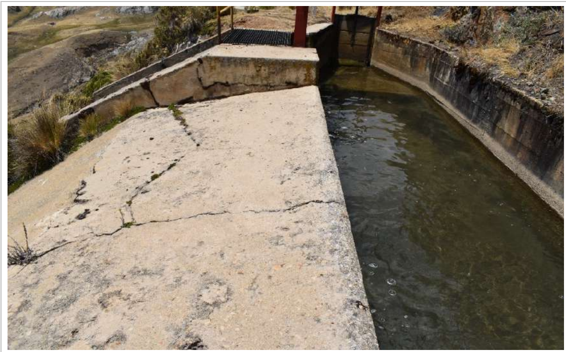
Figura 3.3 - 12 Canal de demasías (vista panorámica)
