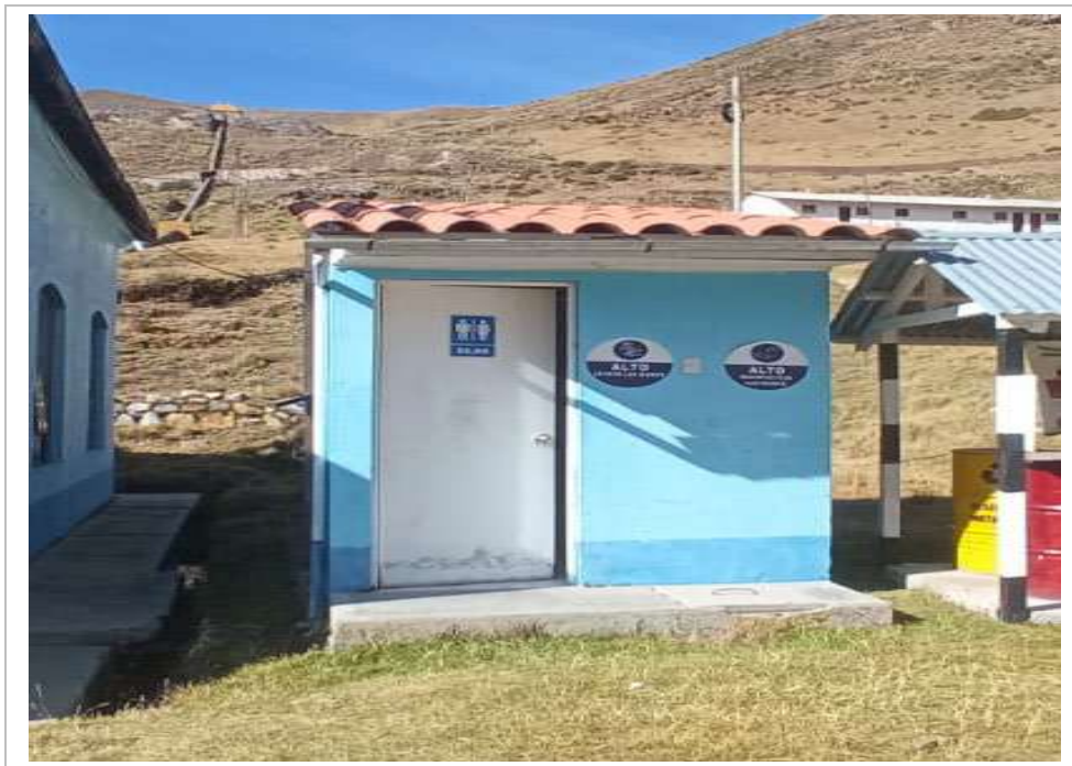
Figura 3.3 - 23 Servicios higiénicos (Ambiente externo)
