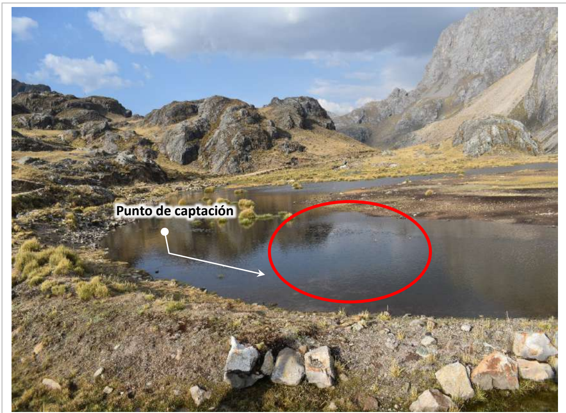
Figura 3.3 - 1 Punto de captación de agua de la Laguna Yanahuin
