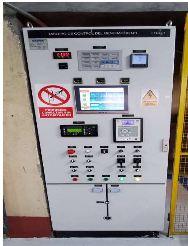
c.2 Generador eléctrico
