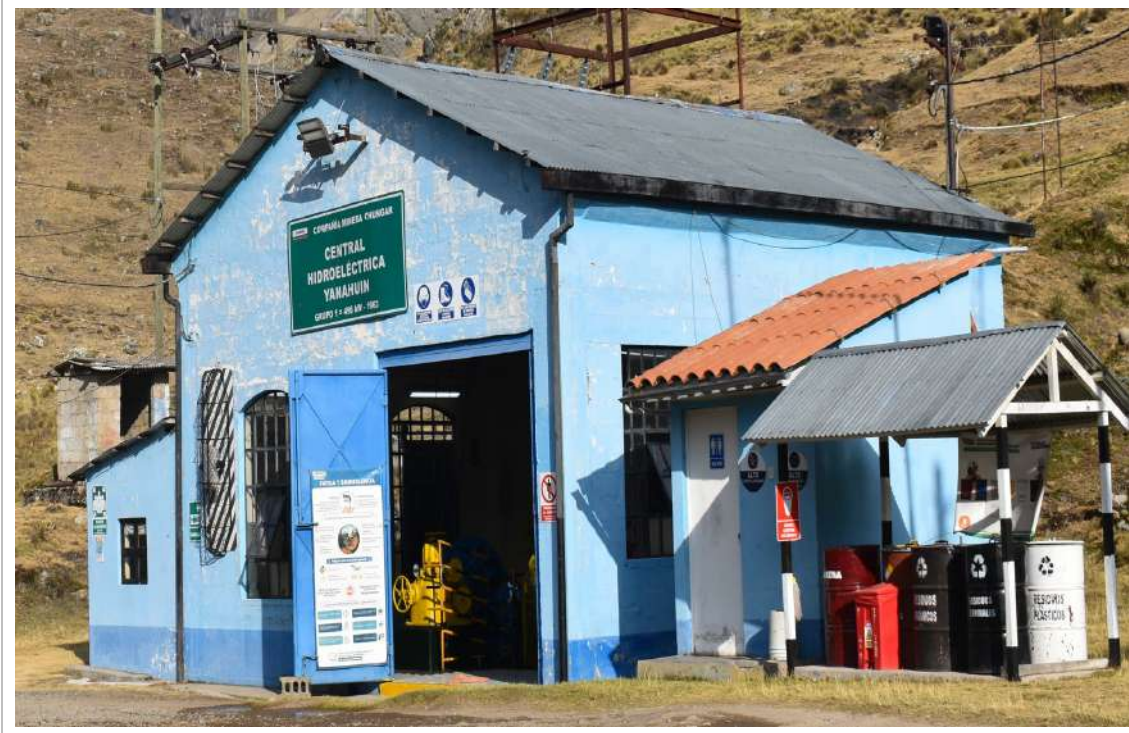
Figura 3.3 - 15 Vista panorámica de la Casa de máquinas
