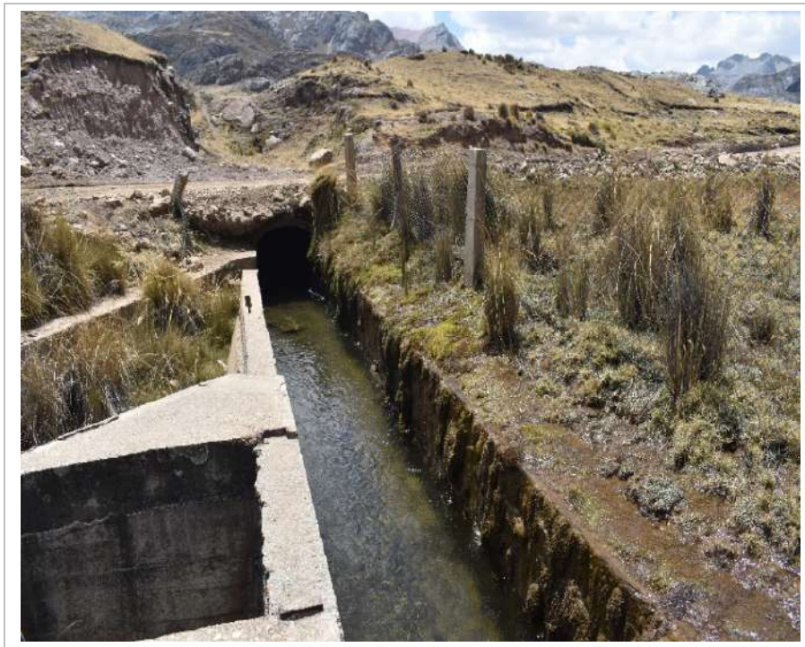
Figura 3.3 – 7 Canal de conducción proveniente de la Bocatoma Yanahuin
