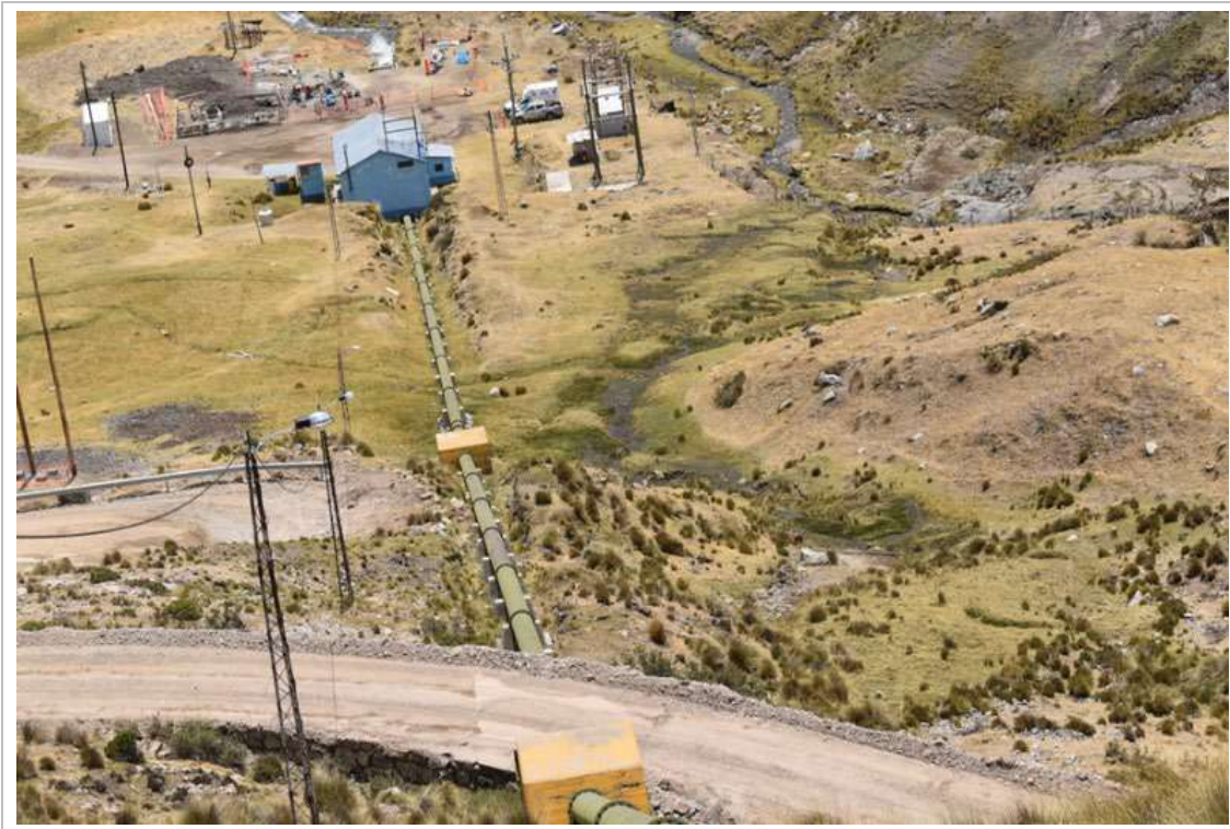
Figura 3.3 - 13 Tubería forzada (Vista panorámica)
