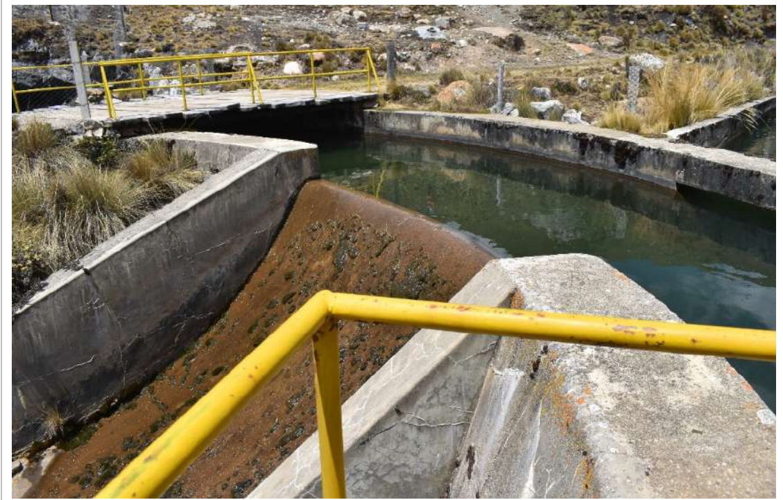
Figura 3.3 - 11 Vertedero lateral de demasías (vista perfil)
