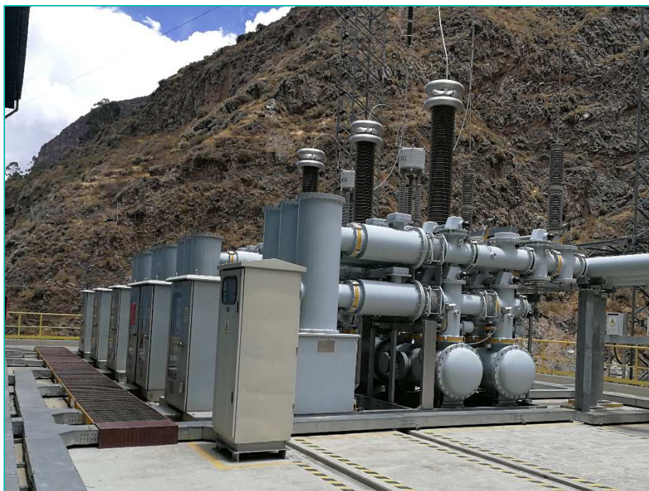
Fotografía 08: Subestación GIS
