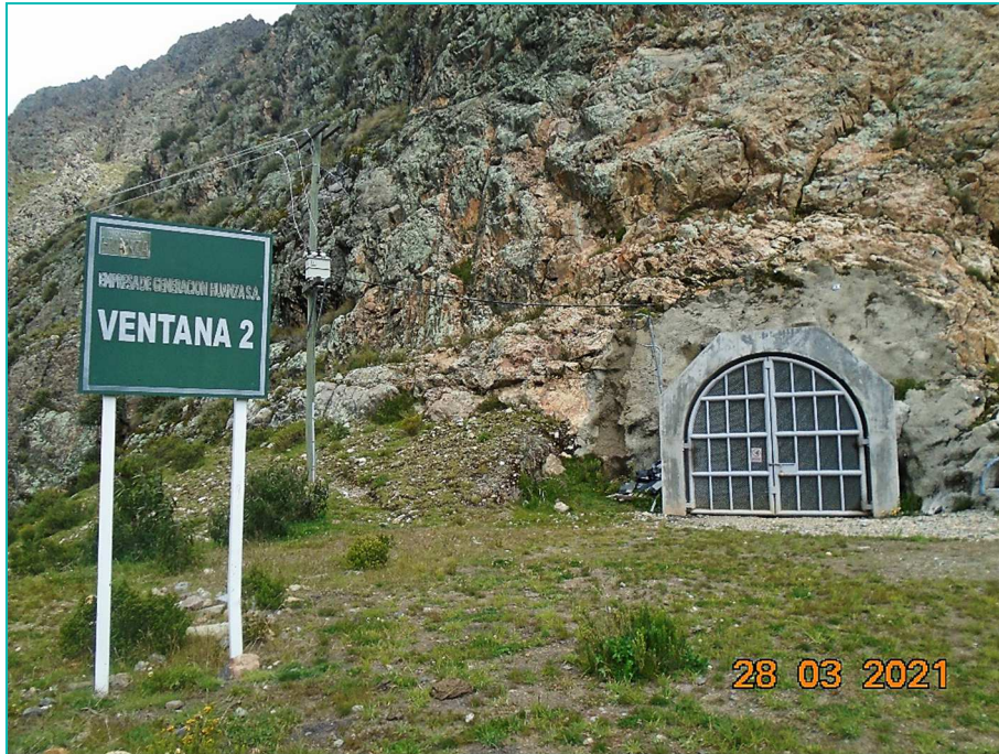
Fotografía 11: Transformador de Distribución - Ventana 2: TD_V2_LT_HZA
