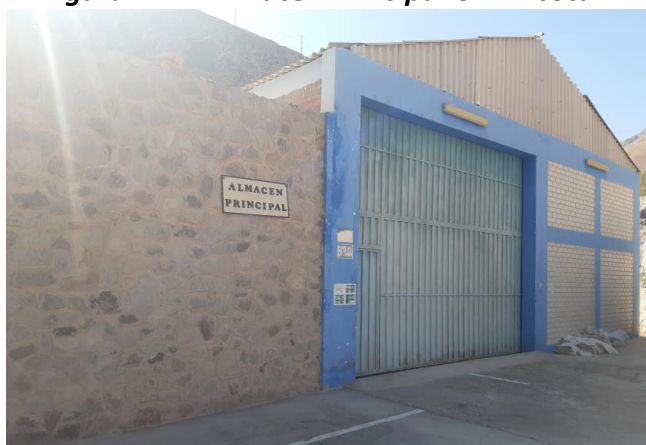
Figura Nº 4: Almacén Principal CH Aricota II
