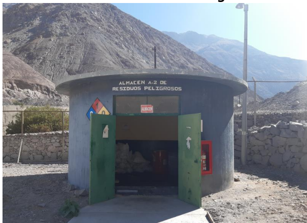
Figura Nº 6: Almacén de Residuos Peligrosos CH Aricota II
