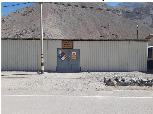
Figura Nº 5: Almacén de Productos Químicos CH Aricota II
