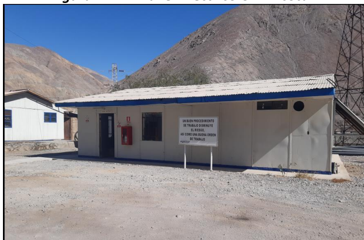
Figura Nº 13: Taller de Mantenimiento CT Independencia
