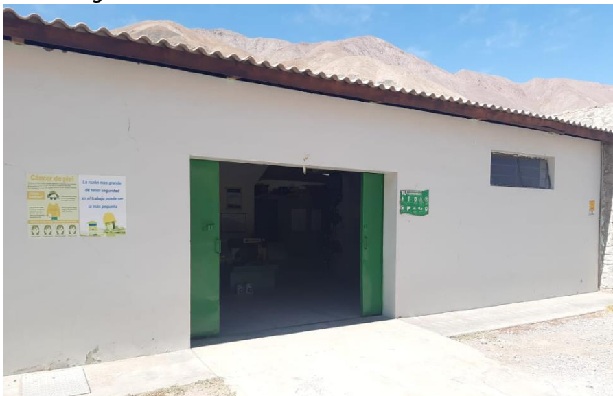
Figura N° 10: Taller de Mantenimiento CH Aricota II
