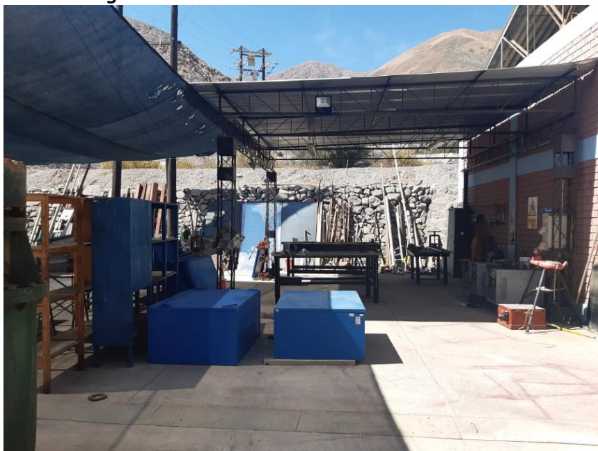
Figura N° 11: Taller de Soldadura CH Aricota II
