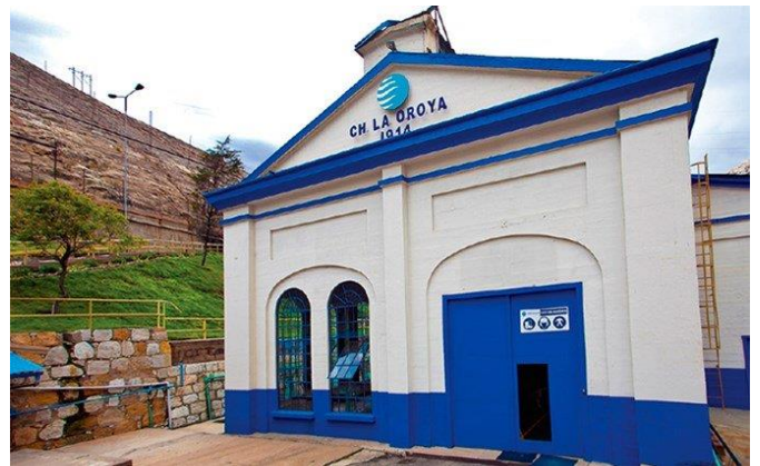
IMAGEN 7 CENTRAL HIDROELÉCTRICA ARCATA
