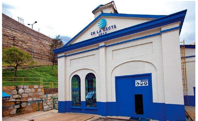
IMAGEN 7 CENTRAL HIDROELÉCTRICA ARCATA
