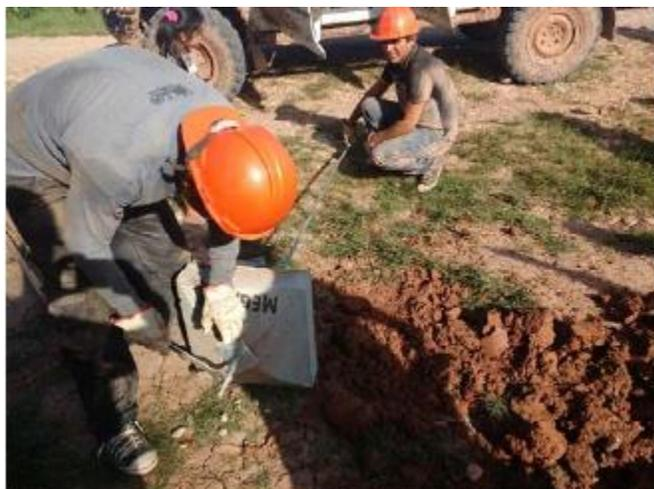
*INSTALACION DE VARILLA DE ANCLAJE EN BLOQUETA DE CONCRETO*
