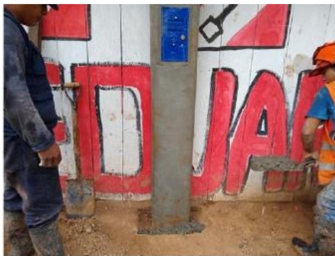
*TRABAJOS DE INSTALACION DE MURETES DE CONCRETO, EN LA CUAL SE ESTÁ REALIZANDO LA COLOCACIÓN DE UNA BASE DE CIMENTACIÓN PARA LA ESTABILIZACION DE DICHOS MURETES*
