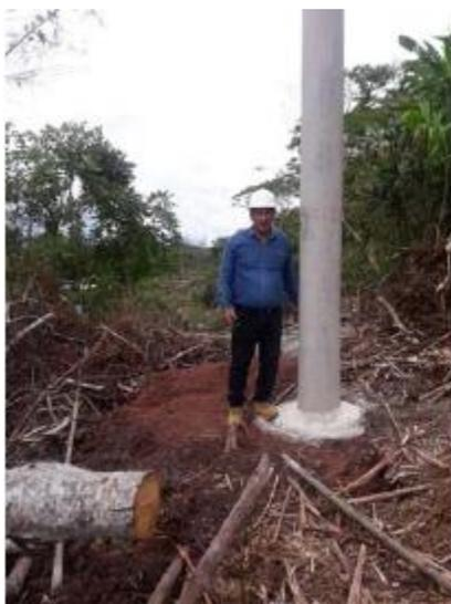
*IZADO DE POSTES DE 12m/300 daN EN REDES PRIMARIA, EN LA CUAL SE APRECIA LA BASE DE CONCRETO CICLOPEO*
