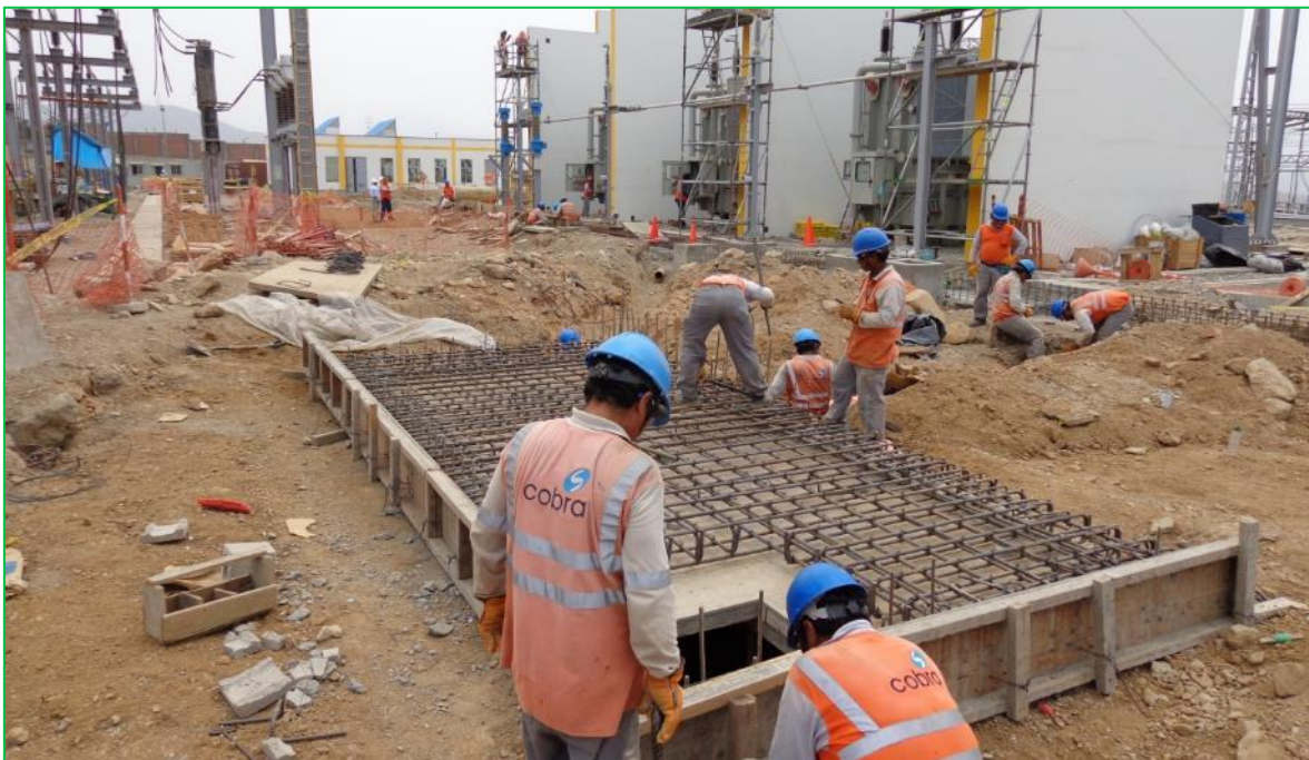
Figura 6.11. Sistema colector de aceite en construcción
