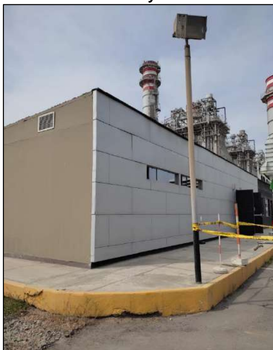
Fotografía 3-1. Exteriores del vestidor y Ambientes de Servicios Generales
