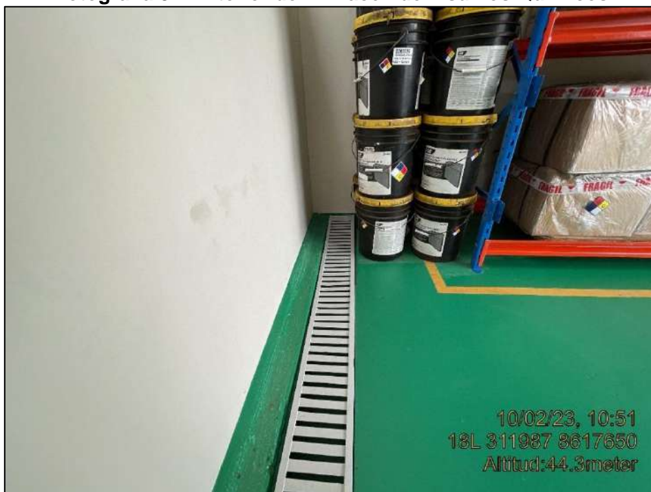
Fotografía 8-1. Interior del Almacén de Insumos Químicos
