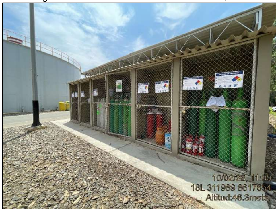
Fotografía 8-4. Exterior del Almacén de Insumos Químicos
