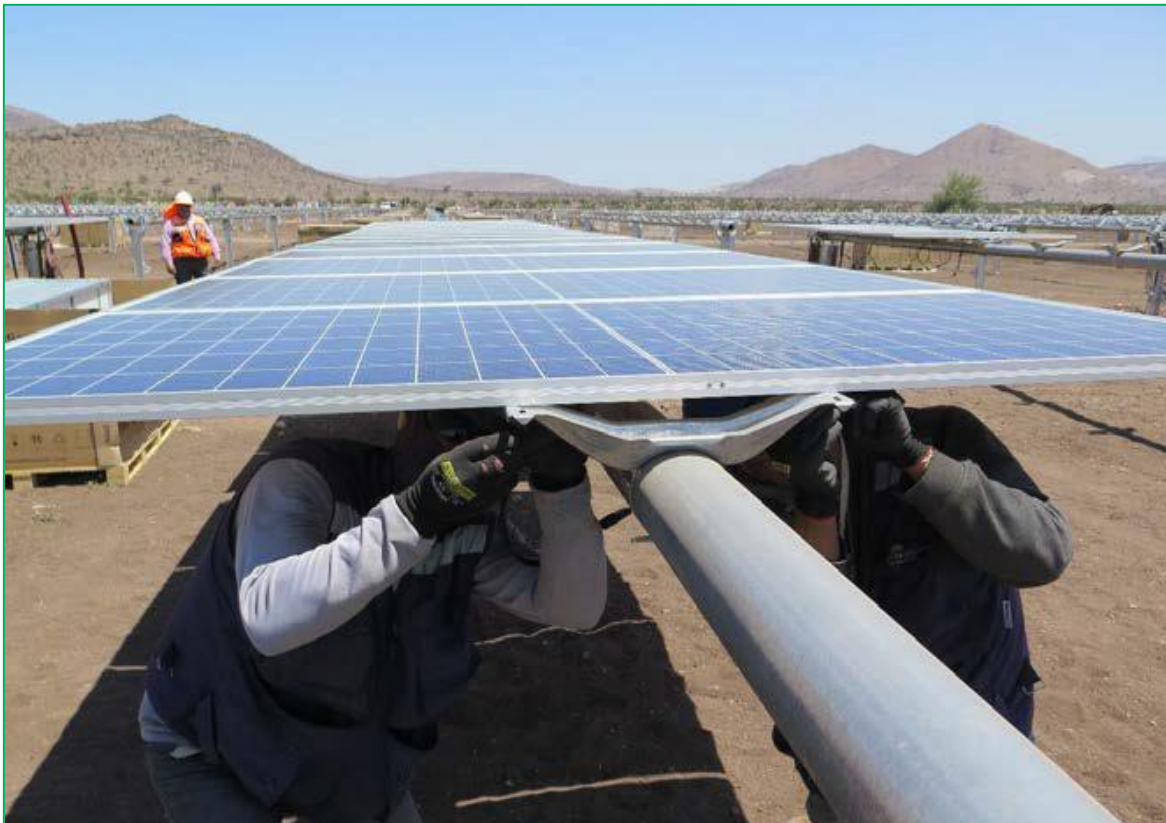
Figura 2.8 Instalación de paneles fotovoltaicos
