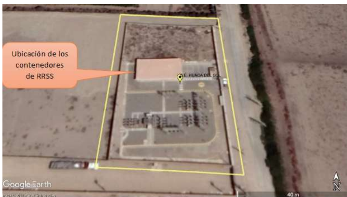
Figura 3. Ubicación del almacenamiento de RRSS
